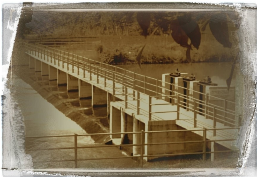
Άποψη του φράγματος Αγίων Κωνσταντίνου και Ελένης Μεγαλοκάμπου
